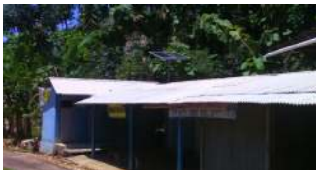
Setiap Usaha Kecil/Menengah Terdapat Panel Surya Sebagai Sumber Tenaga Untuk Penerangan
