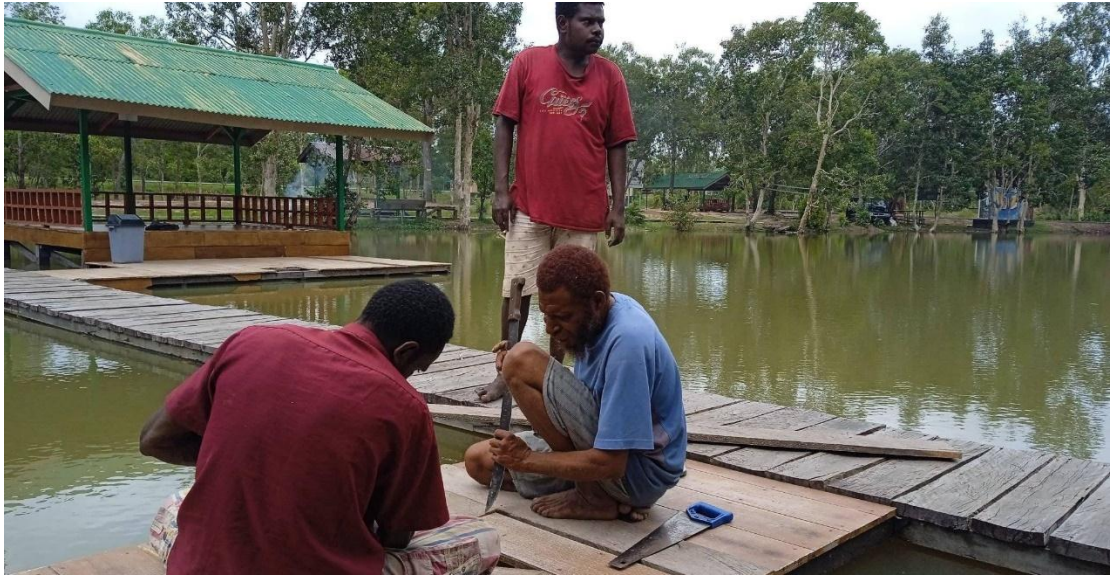
Memperbaiki papan jalan yang rusak
