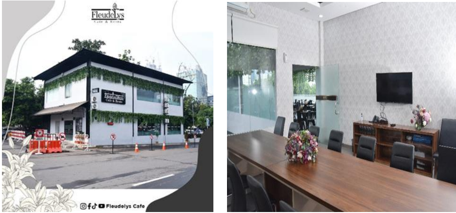
Tampak Luar dan Ruang VIP Room Fleudelys Café & Resto Polda Metro Jaya
