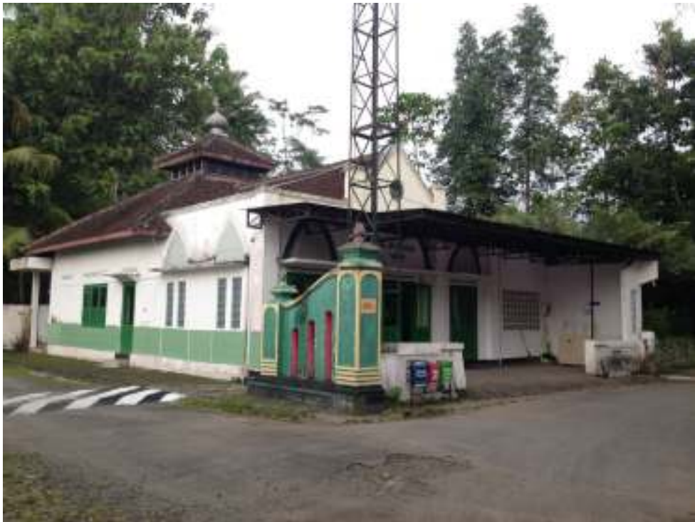
Gambar 15. Masjid di Dusun Dukuh Sumber : Dokumentasi Pribadi
