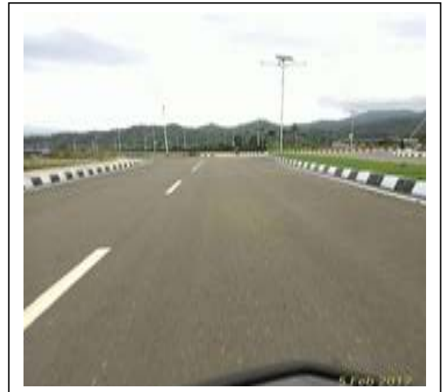
Jalan ke Lokasi Pantai
