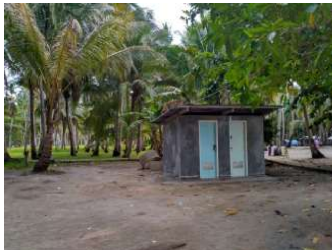
Toilet yang tergolong baru
