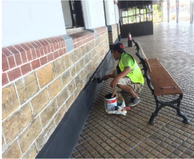
h. Foto karyawan yang sedang memperbaiki warna tembok.
