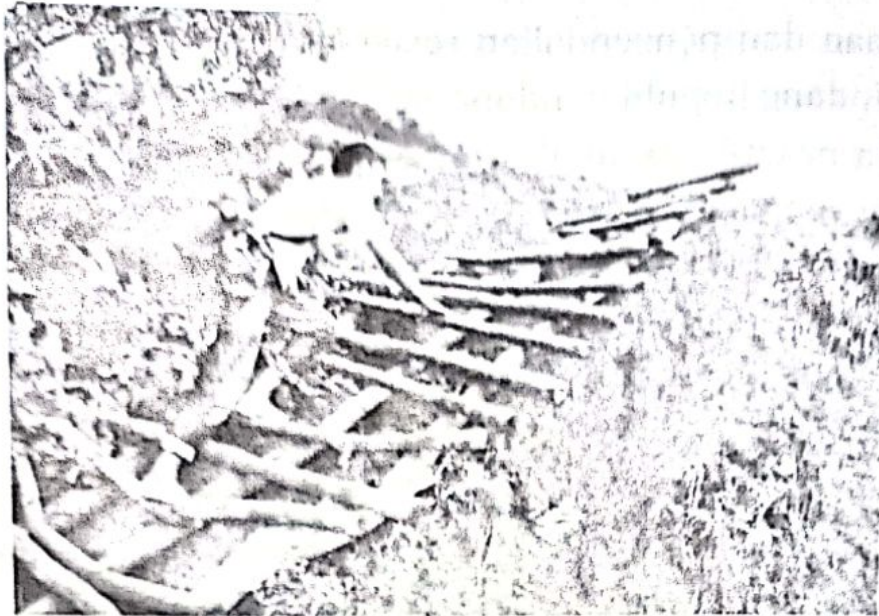
Pembangunan Tangga Pendakian dengan Desain Lokal
